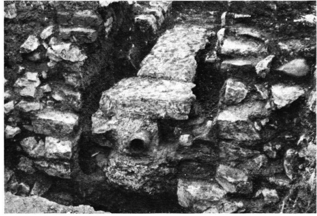
Abb. 3. Windisch, Jurastraße, Teil der verschütteten Wasserleitung mit Tonröhreinbau. Photo O. Lüdlin
