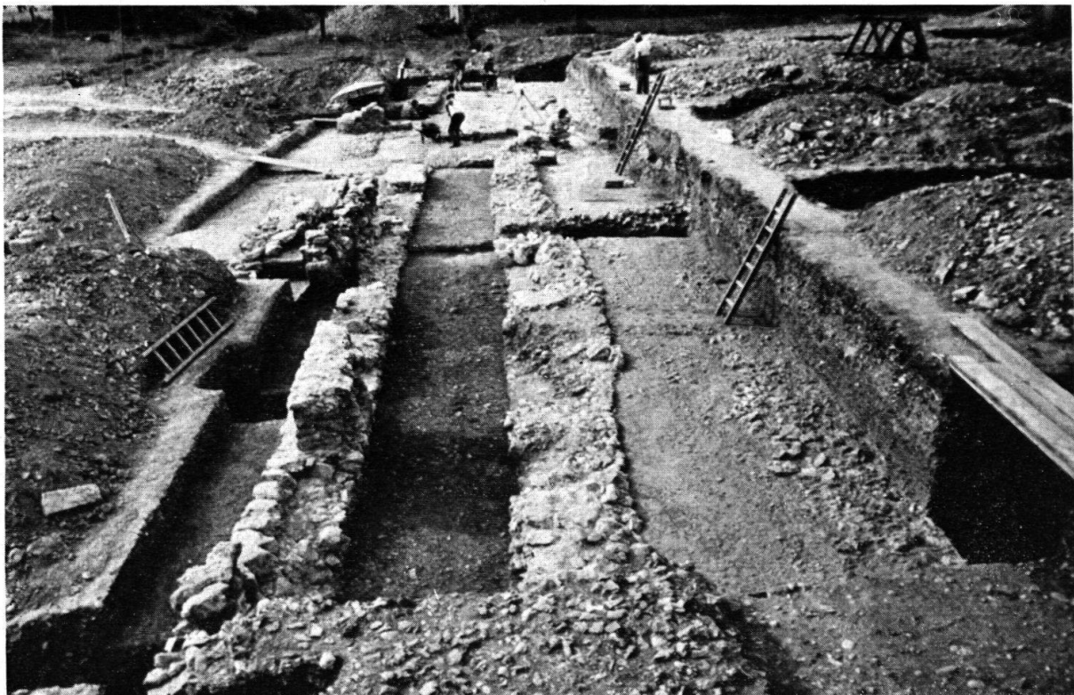
Abb. 3. Windisch, Grabung im neuen Friedhofareal, 1969. Grabungsabschnitt 2 mit den Fundamenten der Lagermauer von Süden gesehen. Photo O. Lüdin.
