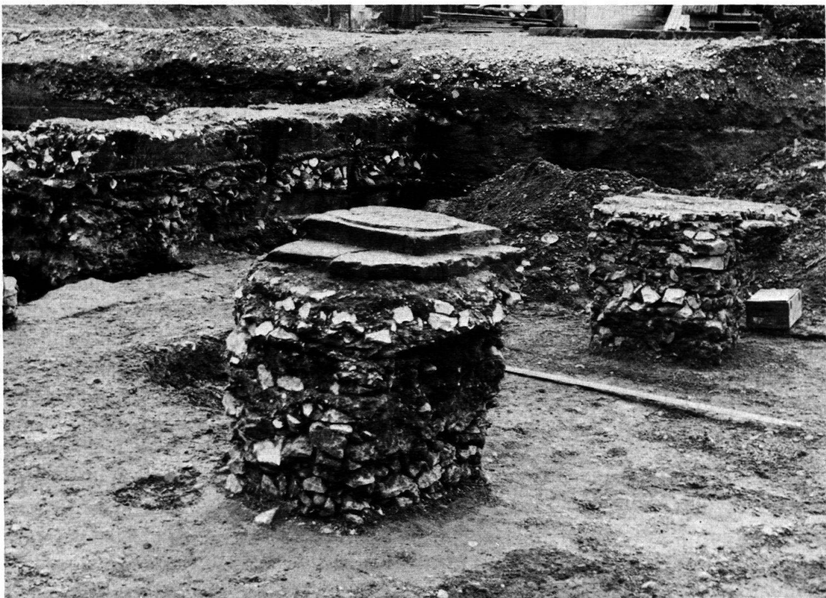
Abb. 6. Windisch-Scheuerhof 1968. Zwei Säulenfundamente der südlichen Säulenreihe in der Lagerbasilica (Baugrube B). Im Hintergrund Fundamentmauer des Apsidenbaus mit Abdrücken der Brettverschalung. Photo O. Lüdin.
