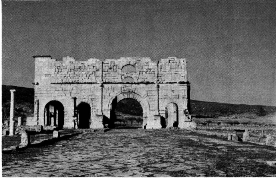
Abb. 58. Legionslager Lambaesis. Blick in der Achse der Via principalis nach Westen gegen den Eingangsquadrifrons der Principia. Aufnahme des Verfassers.
