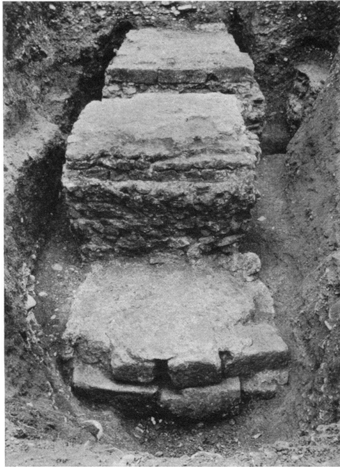
Abb. 5. Fundamentklötze des westlichen Einlaßbogens der Via principalis in die Principia. (Cliché aus ASA.)
