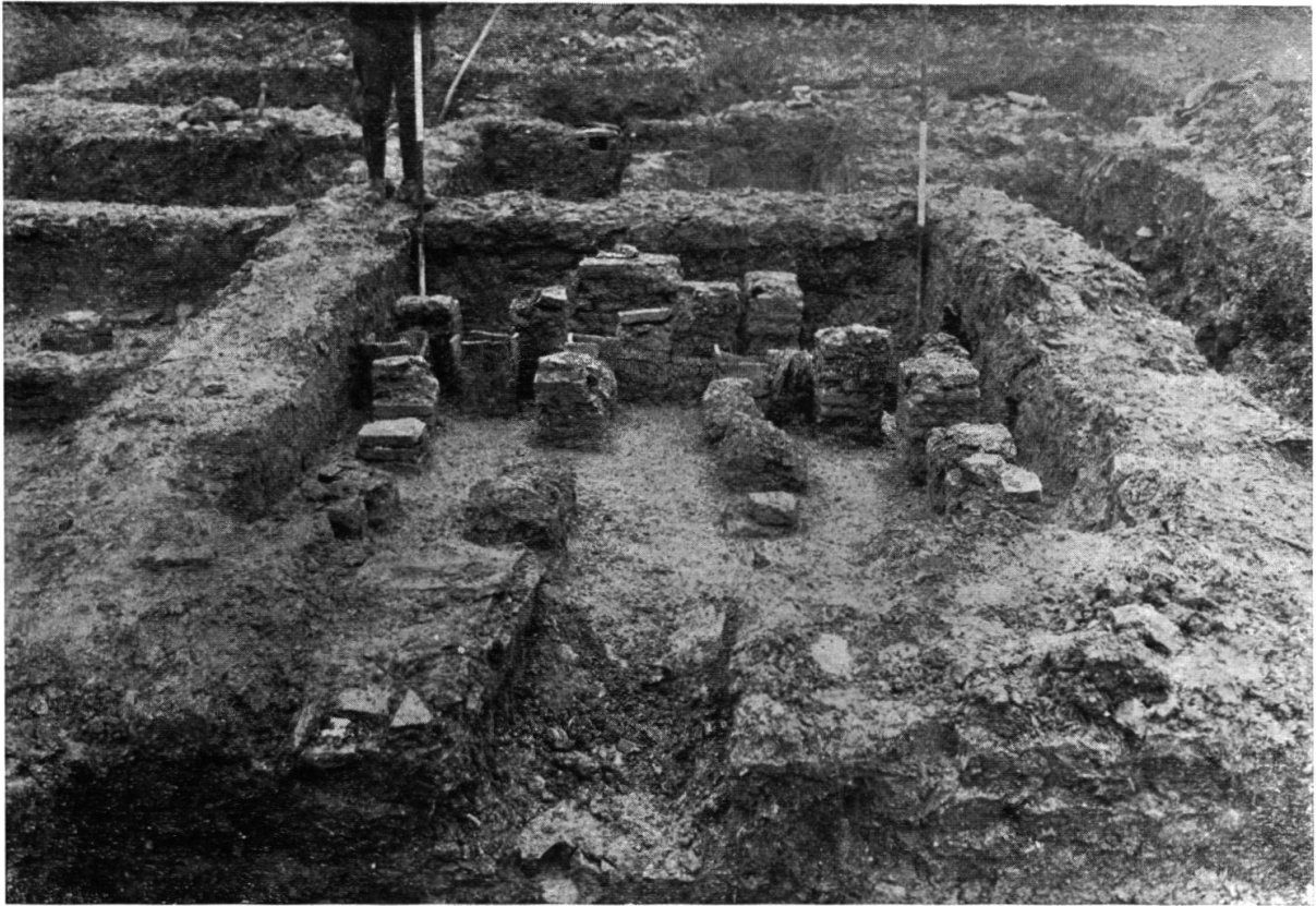
Römischer Gutshof in Bözen. Heizbares Gemäch. Aufgenommen am 11. Januar 1923.
