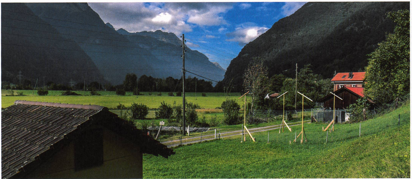
Bauprofile im Silenerboden. Beim Schützenbrunnen entsteht ein neues Pumpwerk.
