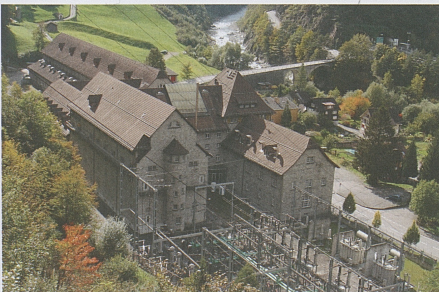
Fast unscheinbar wirken sie, die drei Turbinen im Kraftwerk Amsteg (grosses Bild). Hinter diesen historischen Mauern befinden sich die neuen Bahntechnikinstallationen (kleines Bild).
