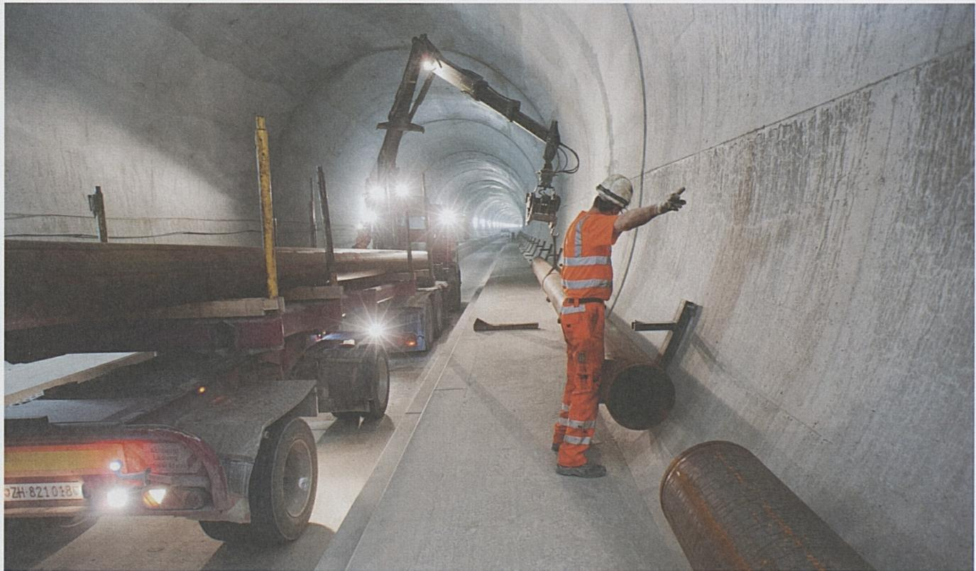
**Der Einbau der bahntechnischen Anlagen im Gotthard-Basistunnel läuft auf Hochtouren. In der Oströhre zwischen Erstfeld und Sedrun wurden in den vergangenen Monaten sämtliche temporären Anlagen installiert. Zurzeit bauen die Gleisbauer die feste Fahrbahn von Erstfeld bis nach Sedrun ein.**
