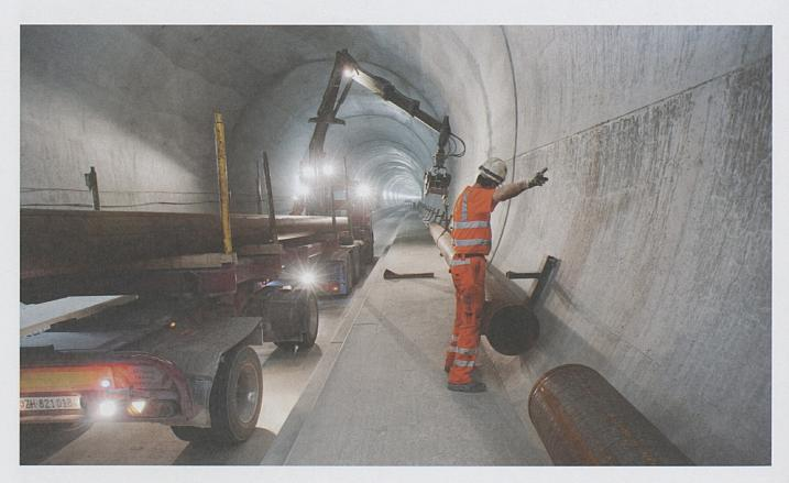
Der Einbau der bahntechnischen Anlagen im Gotthard-Basistunnel läuft auf Hochtouren. In der Oströhre zwischen Erstfeld und Sedrun wurden in den vergangenen Monaten sämtliche temporären Anlagen installiert. Zurzeit bauen die Gleisbauer die feste Fahrbahn von Erstfeld bis nach Sedrun ein.
