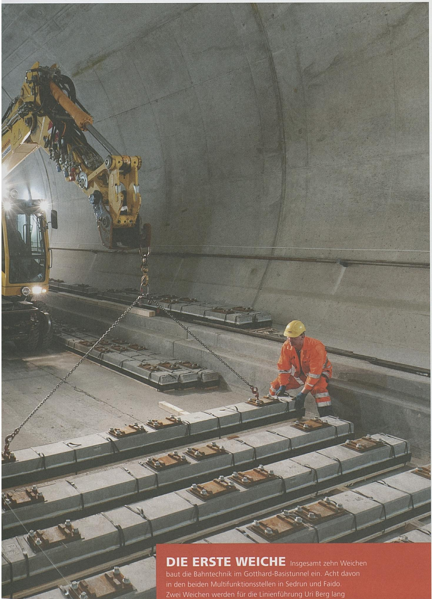
**DIE ERSTE WEICHE** Insgesamt zehn Weichen baut die Bahntechnik im Gotthard-Basistunnel ein. Acht davon in den beiden Multifunktionsstellen in Sedrun und Faido. Zwei Weichen werden für die Linienführung Uri Berg lang vorbereitet, um zu einem späteren Zeitpunkt die Umfahrung des Urner Talbodens realisieren zu können.
