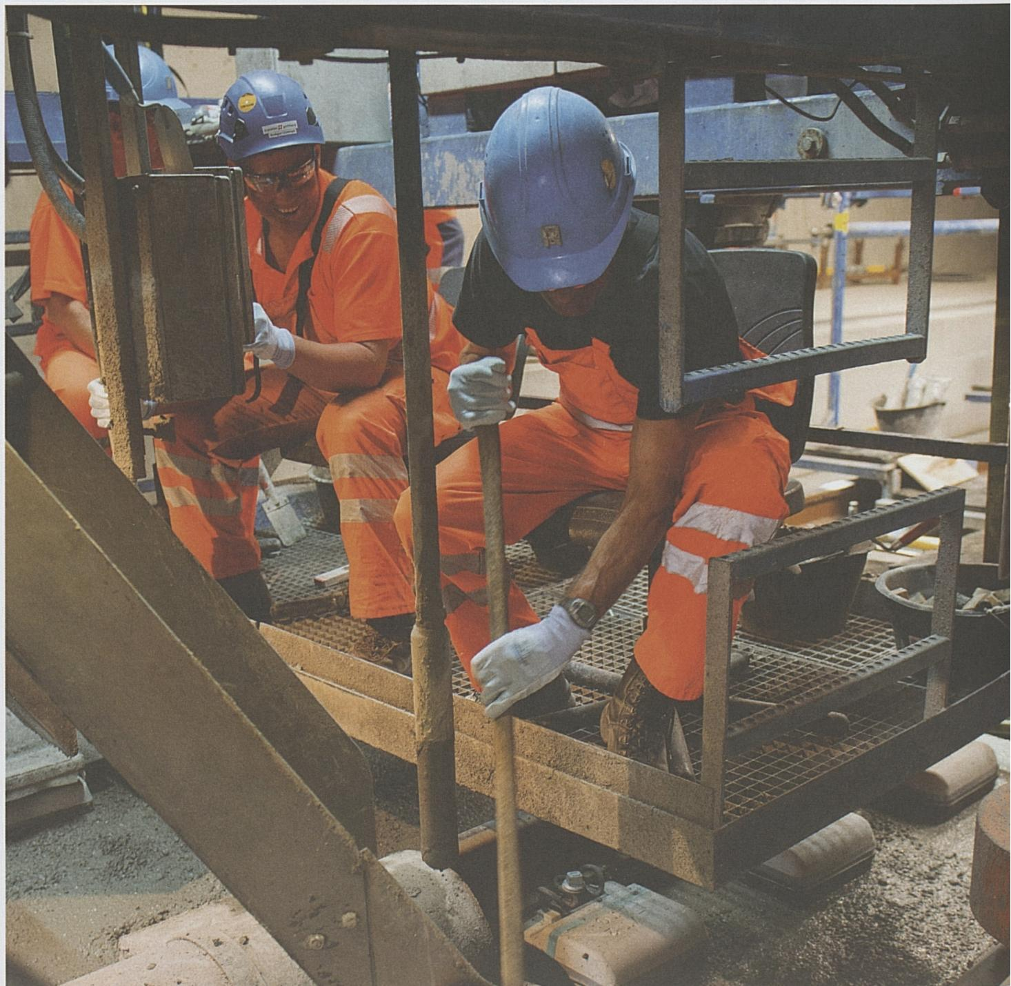
**Am 30. August 2012 hat die Mannschaft des Betonzugs Sedrun erreicht. Damit ist die Feste Fahrbahn in der Oströhre von Erstfeld bis Sedrun eingebaut. Parallel dazu hat der Einbau der Fahrleitung begonnen.**
