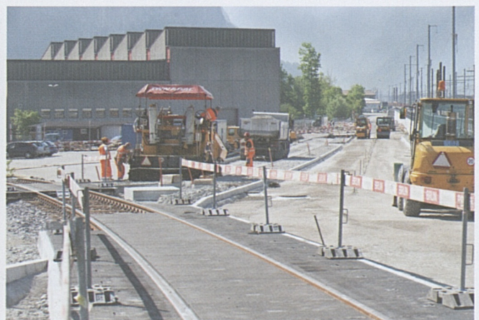
Entlang der offenen Strecke Altdorf/Rynächt wird die Kantonstrasse Stück für Stück fertiggestellt.
