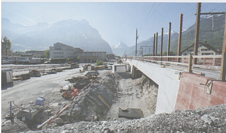
Neue Zufahrt nach Attinghausen: Die Unterführung Wysshus ist im Bau und wird voraussichtlich im Herbst 2012 eröffnet.
