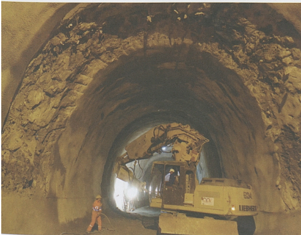
Vezia: Arbeiten in der Oströhre.
