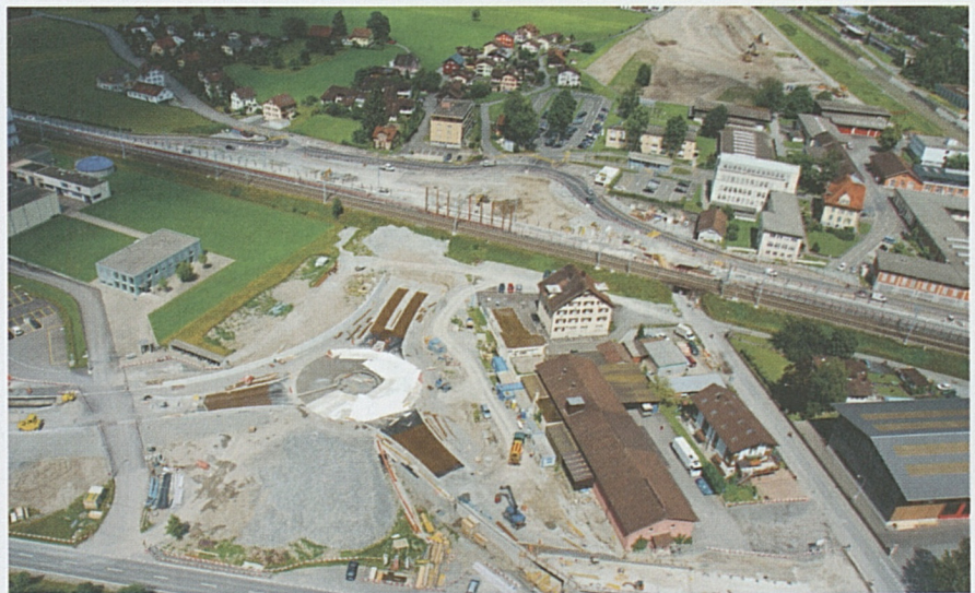
Altdorf/Rynächt: Der neue Verkehrsknotenpunkt Wysshus nimmt Formen an.
