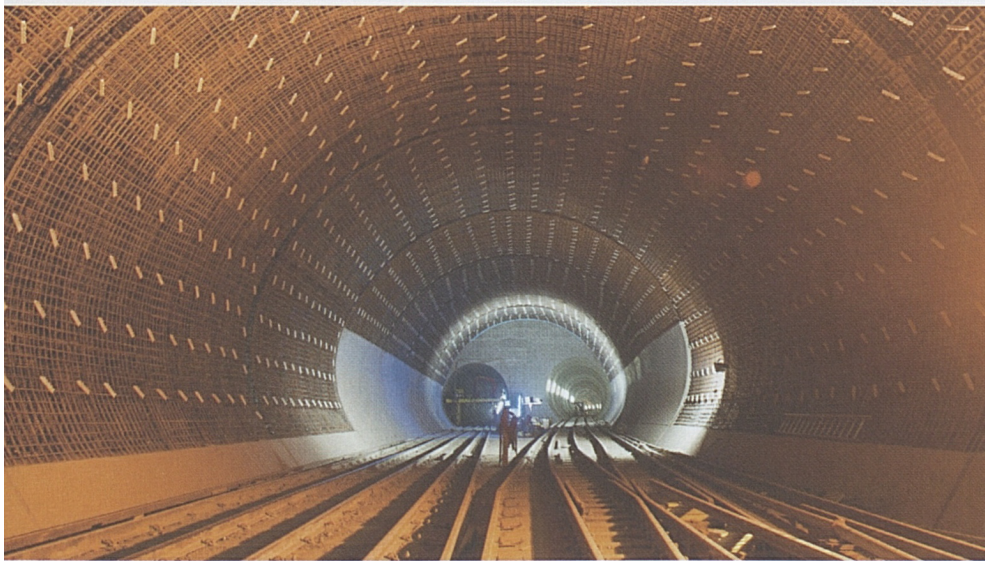
Faido: Armierte Tunnelwechselaufweitung – bereit für die Betonarbeiten.
