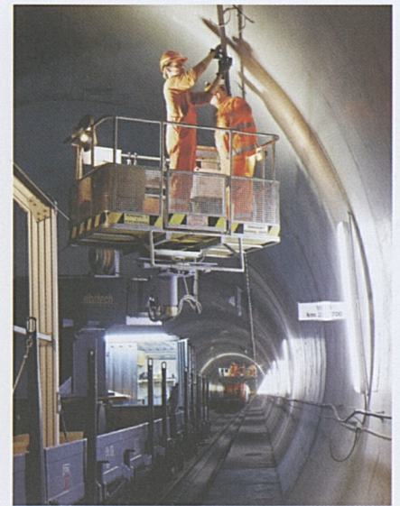
Bodio: Montagearbeiten für die Bahntechnik.
