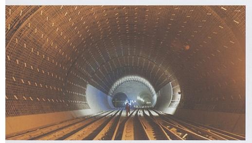
Faido: Armierte Tunnelwechselaufweitung – bereit für die Betonarbeiten.
