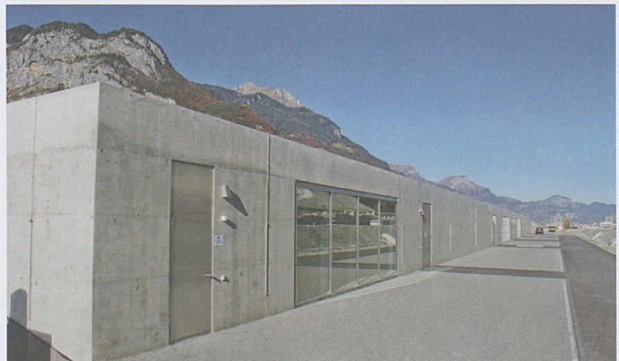
Im Rohbau fertiggestellt: das Bahntechnikgebäude vor dem Nordportal.
