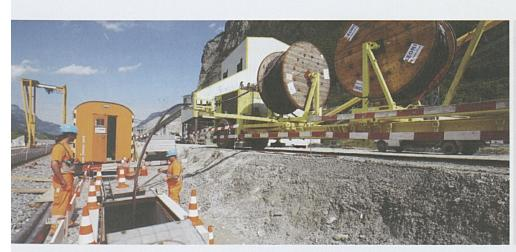
Auch vor dem Tunnel müssen Kabel für die Bahntechnik eingezogen werden.
