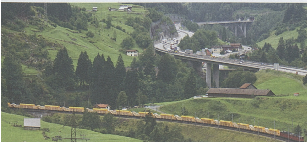
Auf dem Weg in den Norden: Der 400 m lange Betonzug wird von Biasca nach Erstfeld auf den Installationsplatz Rynächt überführt.
