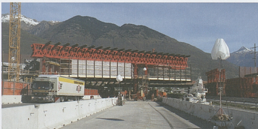
Neue Brücke über die Autobahn A2 bei Camorino.
