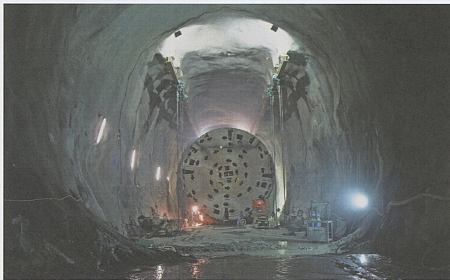
Sedrun: Demontage der Tunnelbohrmaschine in der grossen Kaverne.
