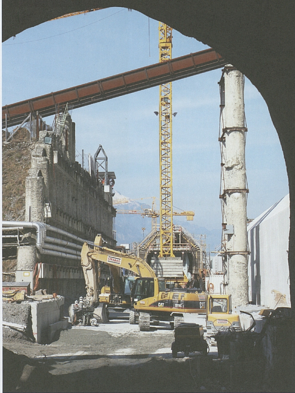
Erstfeld: Noch wenige Meter fehlen bis zum Anschluss des Tagbautunnels an den Berg.
