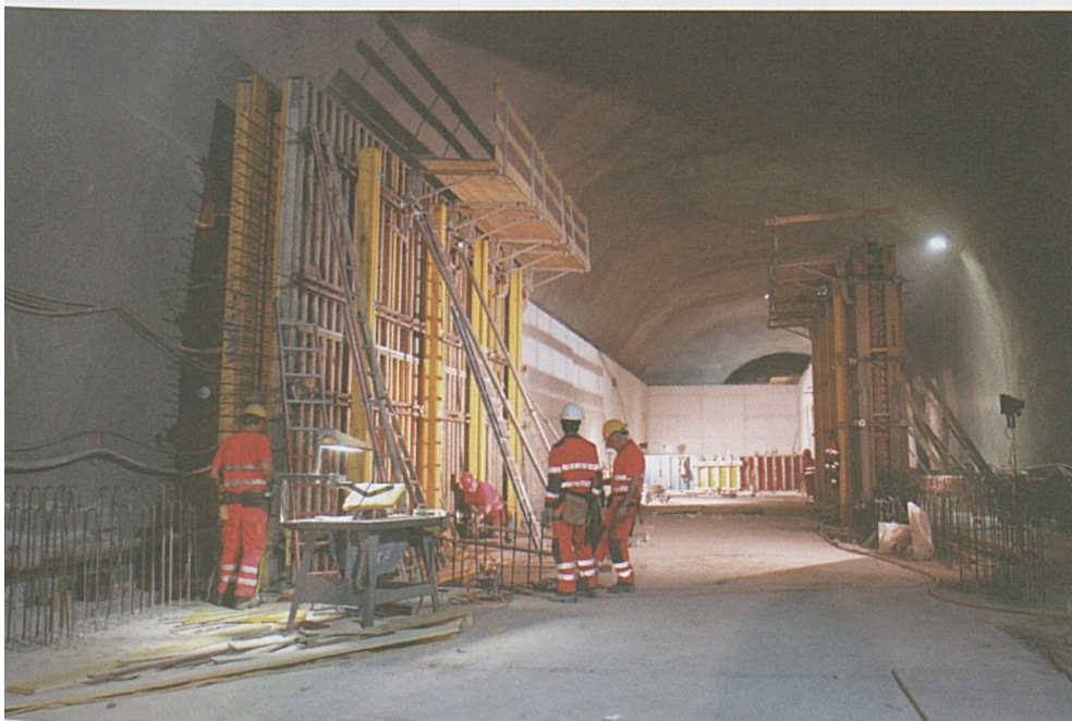
Amsteg: Bau des Bahntechnikgebäudes.
