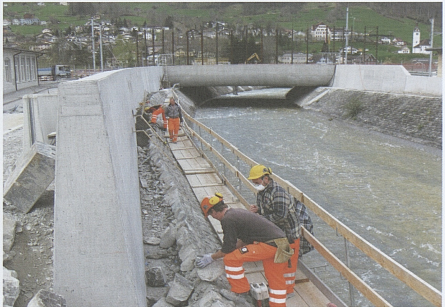
Druckbrücke über den Schächen mit den seitlichen Kragenmauern.
