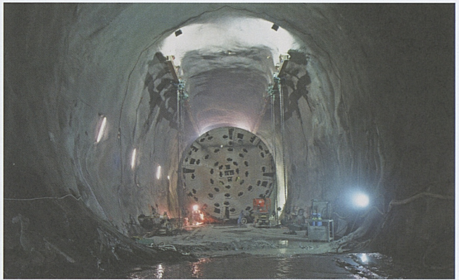
Sedrun: Demontage der Tunnelbohrmaschine in der grossen Kaverne.
