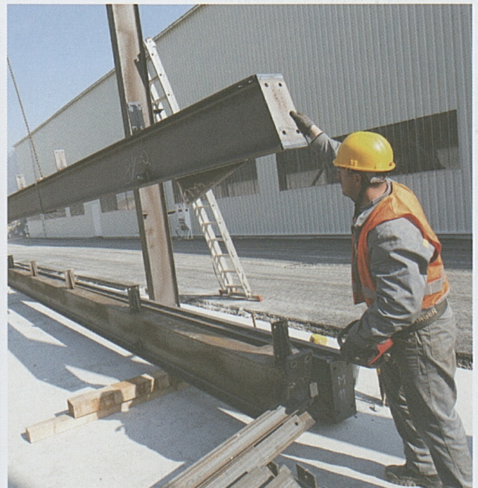
Metallbauer stellen die Hallen für die Bahntechnik im Rynächt auf.
