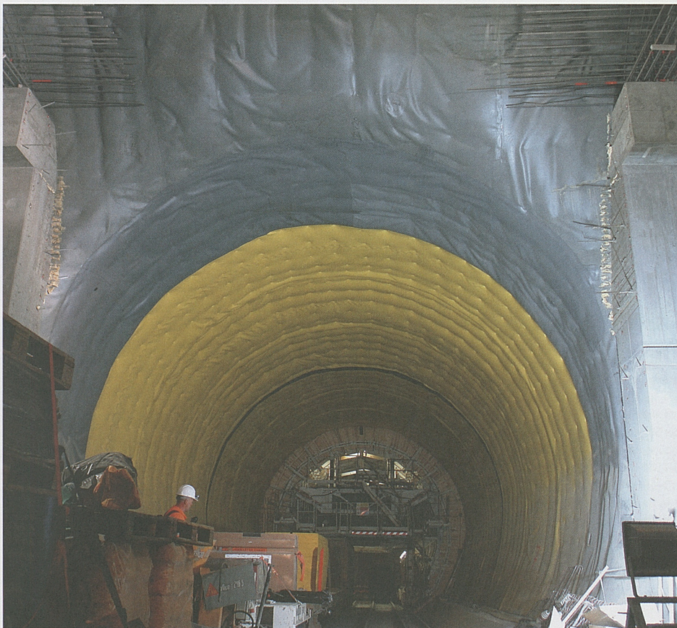
Beim Rohbau des Gotthard-Basistunnels werden Tornischen gebaut, in denen später die Spurwechsellöre Platz finden.
