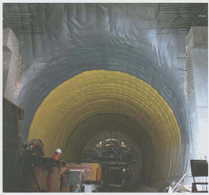
Beim Rohbau des Gotthard-Basistunnels werden Tornischen gebaut, in denen später die Spurwechseltore Platz finden.
