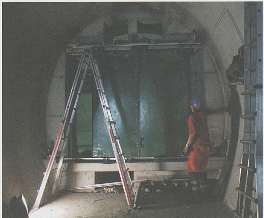
Einbau der Querschlagstüren: Im Teilabschnitt Amsteg sind bereits sämtliche Querschläge fertiggestellt. Im Teilabschnitt Erstfeld beginnt die Ausrüstung im Verlaufe dieses Jahres.
