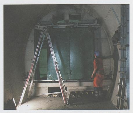
Einbau der Querschlagstüren: Im Teilabschnitt Amsteg sind bereits sämtliche Querschläge fertiggestellt. Im Teilabschnitt Erstfeld beginnt die Ausrüstung im Verlaufe dieses Jahres.
