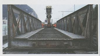
Die SBB-Brücke von 1882 wird mit einem 60-Tonnen Kran weggeführt.
