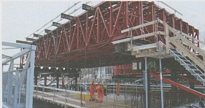
Das riesige Lehrgerüst für die Druckbrücke über den Schächenbach ist installiert.
