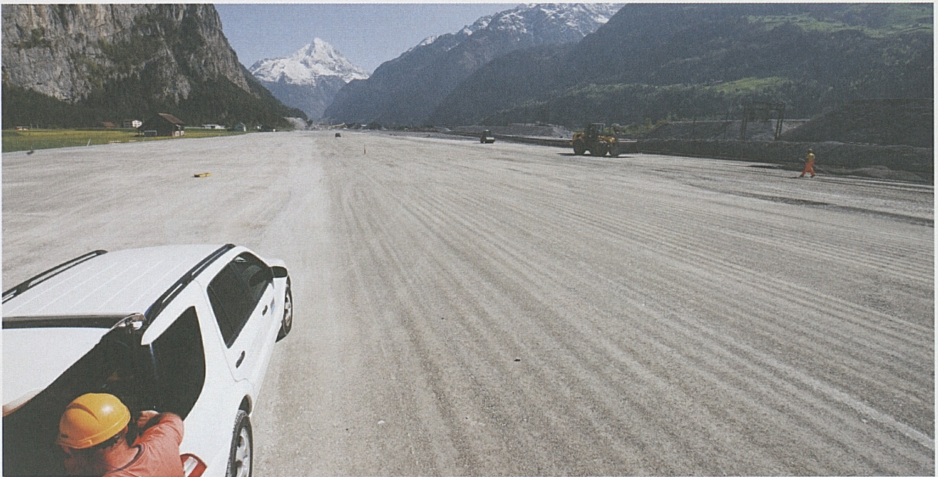
Der Bahntechnik-Installationsplatz im Rynächt wird vorbereitet. Im Herbst 2010 beginnen die Installationsarbeiten der Gebäude und Gleise.
