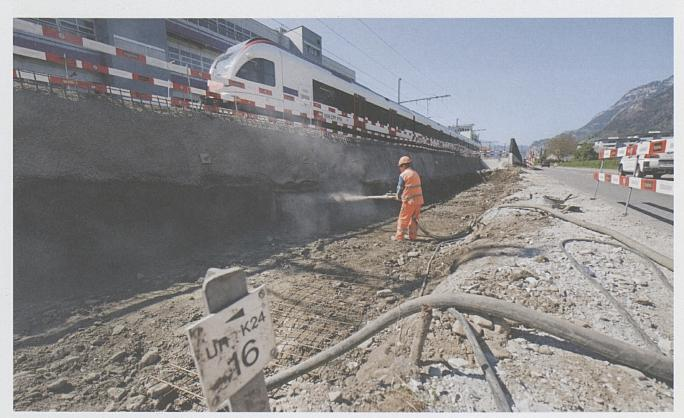
Vorbereitungsarbeiten für die Stützmauern entlang der SBB-Stammlinie: Spritzbeton und Anker stabilisieren das Eisenbahntrassee
