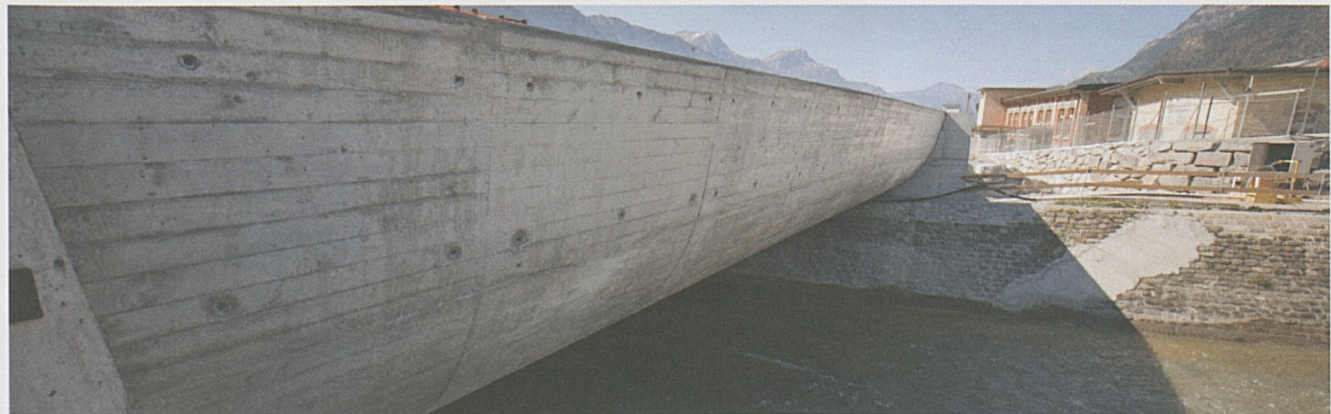
Die Druckbrücke über den Schächenbach nach den Betonarbeiten.
