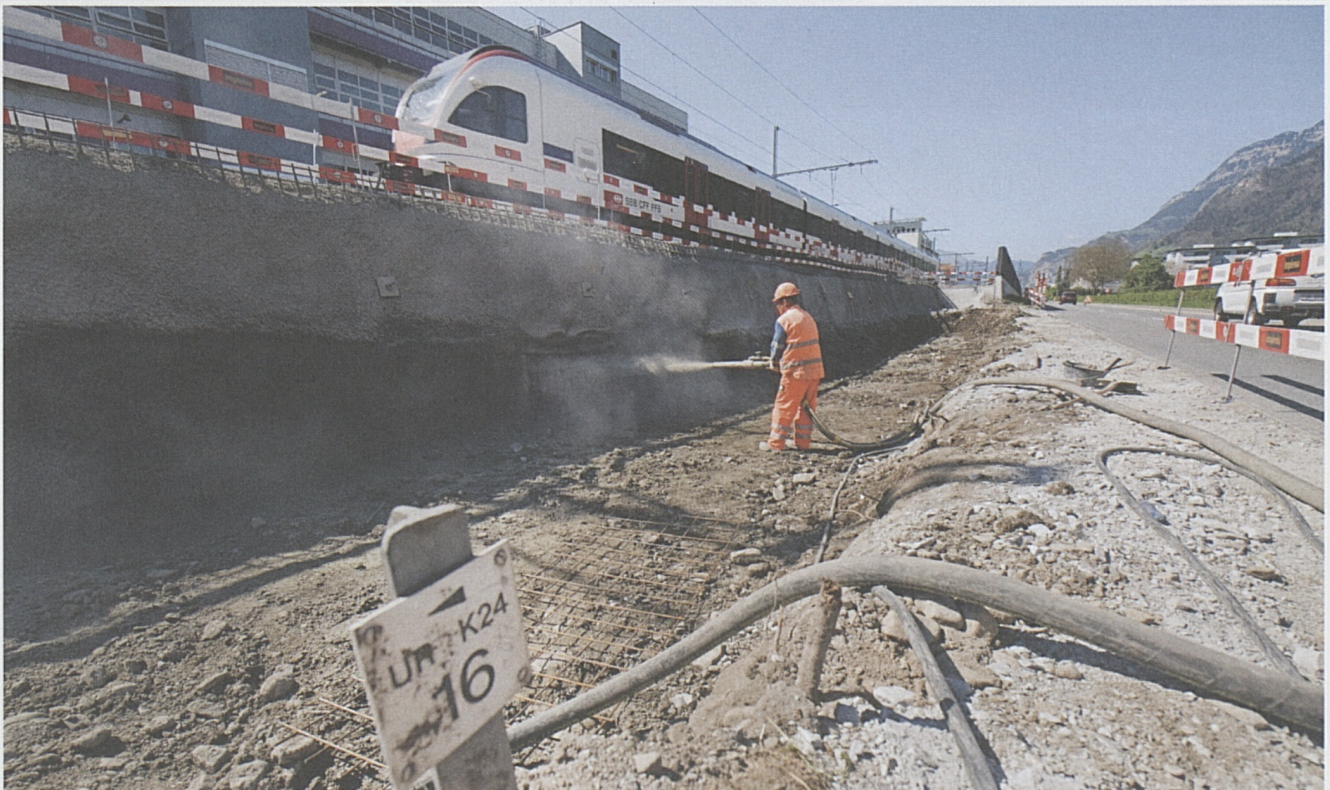
Vorbereitungsarbeiten für die Stützmauern entlang der SBB-Stammlinie: Spritzbeton und Anker stabilisieren das Eisenbahntrasse.
