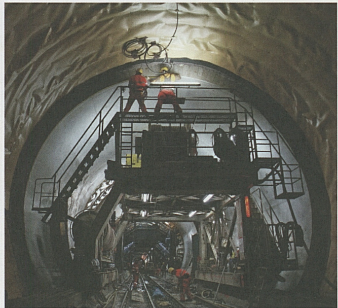
Das rund 30 cm dicke Innengewölbe ist betoniert.
