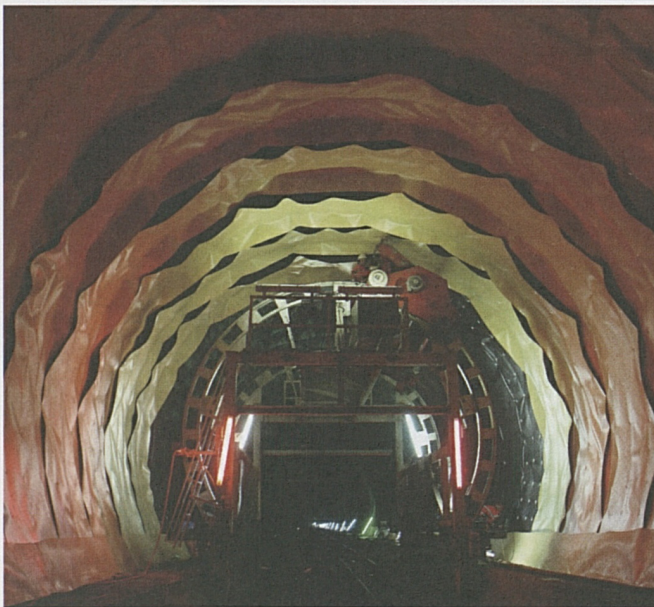
Der Innenausbau in Erstfeld hat begonnen: In der Oströhre werden die Abdichtungsfolien eingebracht.
