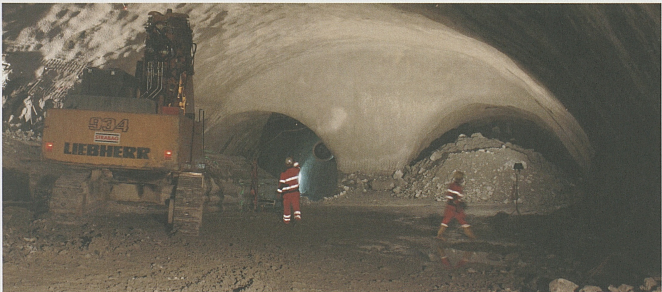
Das im Bau befindliche Verzweigungsbauwerk in der Oströhre bei Erstfeld. Links die Einspuröhre, rechts die abzweigende Röhre.
