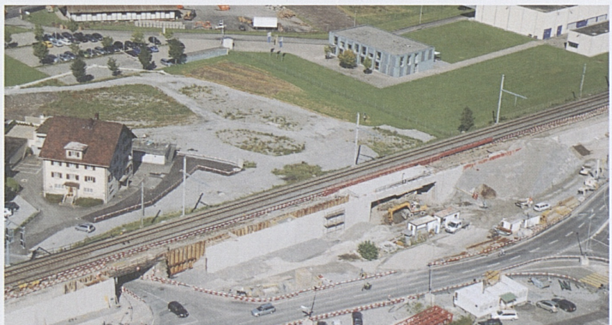
Altdorf/Rynächt: Stützmauern und Vorbereitungsarbeiten für die Unterführung Wysshus (links).
