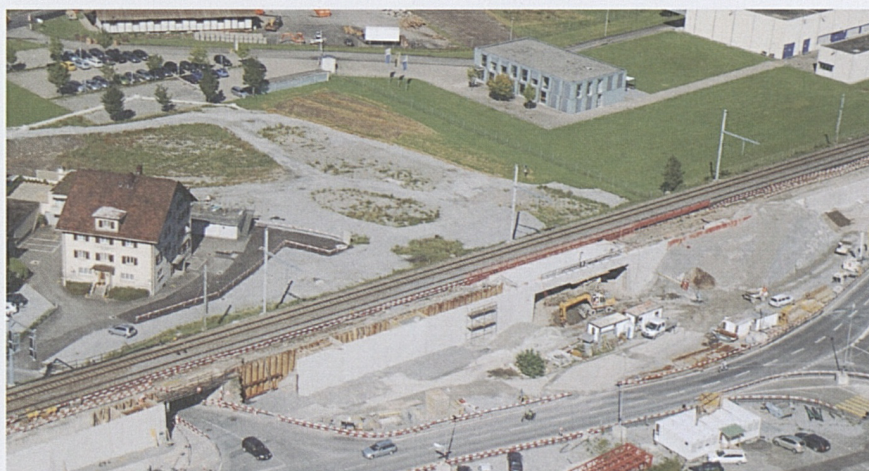
Altdorf/Rynächt: Stützmauern und Vorbereitungsarbeiten für die Unterführung Wysshus (links).
