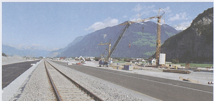
Bahntechnikinstallationsplatz Rynächt: Rohbauarbeiten für die temporären Gebäude.
