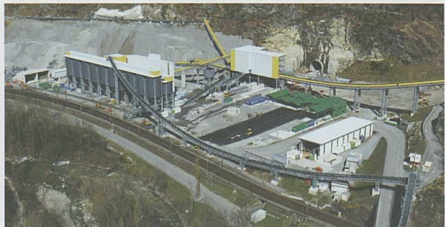
Die Baustelle des Ceneri-Basistunnels in Sigirino.
