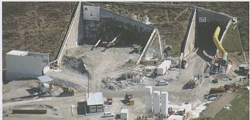
Das Nordportal des Ceneri-Basistunnels in Camorino.
