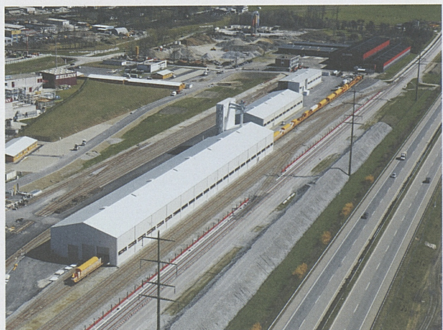
Der Bahntechnik-Installationsplatz in Biasca neben der Autobahn A2.
