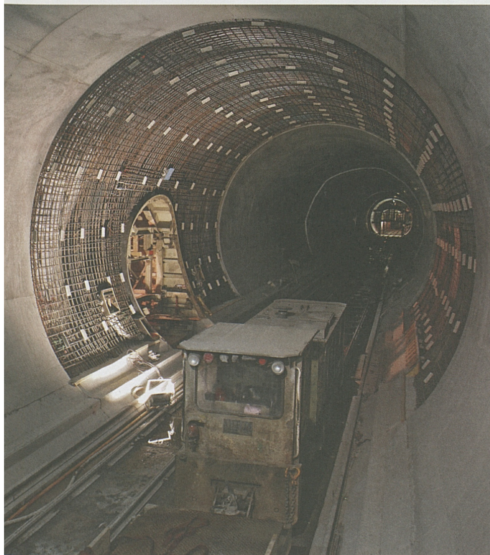
Sedrun: Armierung eines Querschlages.
