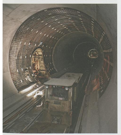
Sedrun: Armierung eines Querschlages.
