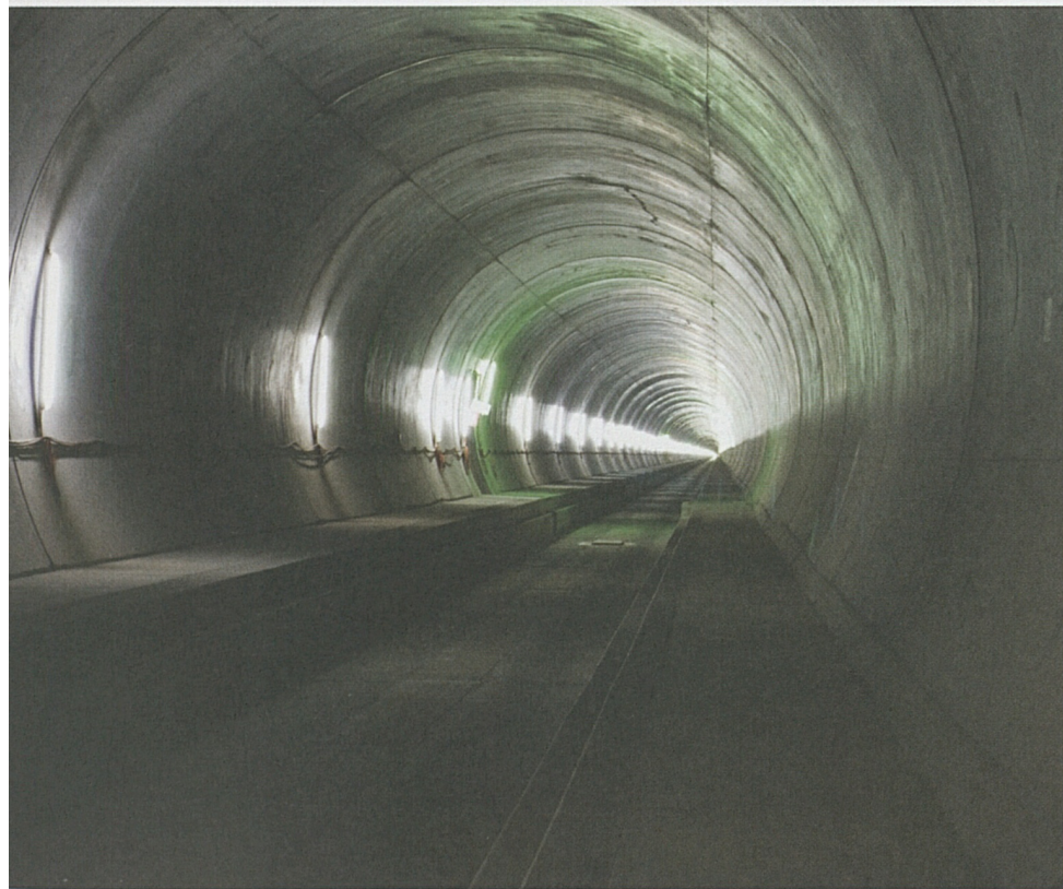
Bereit für den Einbau der Bahntechnik: die Weströhre im Teilabschnitt Amsteg.
