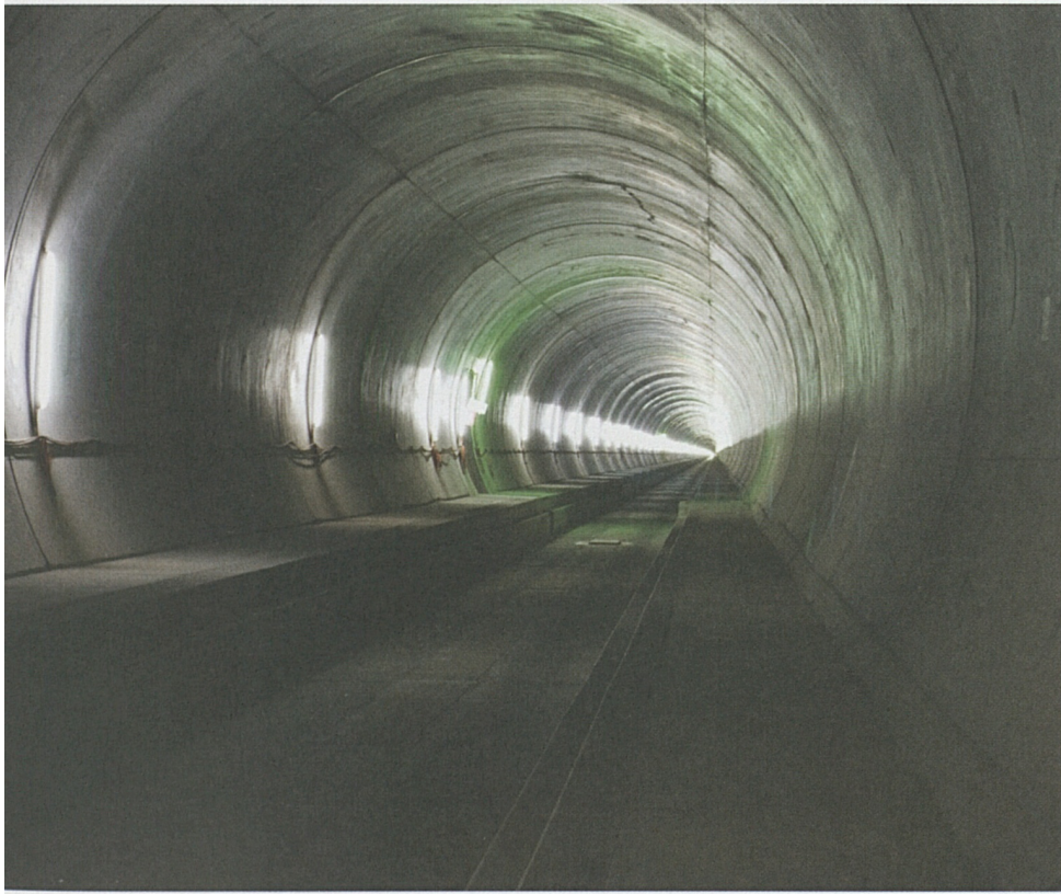
Bereit für den Einbau der Bahntechnik: die Weströhre im Teilabschnitt Amsteg.
