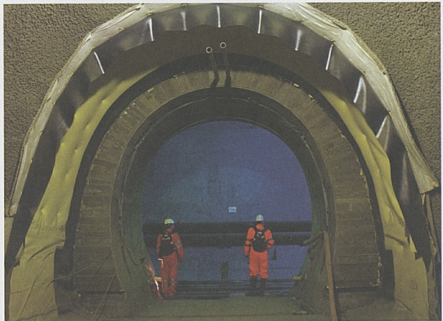
Faido: Blick aus Querschlag 58 in die Oströhre.
