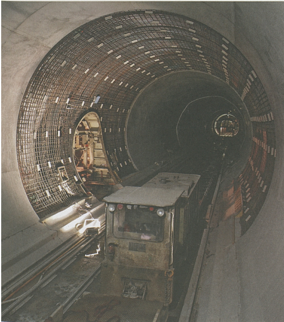
Sedrun: Armierung eines Querschlages.
