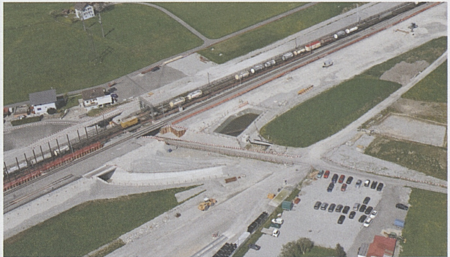
Offene Strecke Aldorf/Rynächt mit der neuen Unterführung Riedstrasse.
