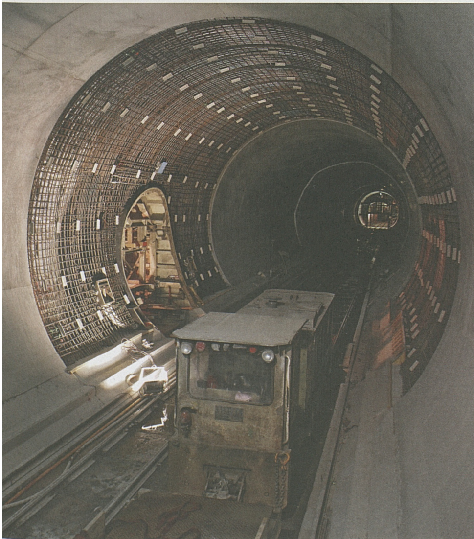
Sedrun: Armierung eines Querschlages.
