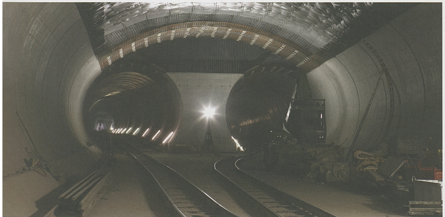
Tunnelwechselaufweitung in Sedrun: Eine riesige Fläche muss betoniert werden.
