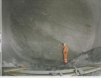
Faido Oströhre: Tunnelbrust mit Mineur mit dem Muster der Rollenmeissel an der Tunnelbrust.
