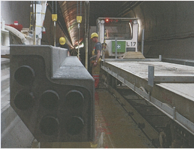
Amsteg Oströhre: Einbau der vorgefertigten Bankettelemente.
