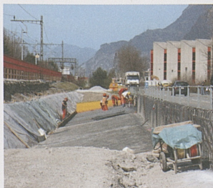
Stützmauer Stille Reuss Süd: vom Fundamentbau ...
