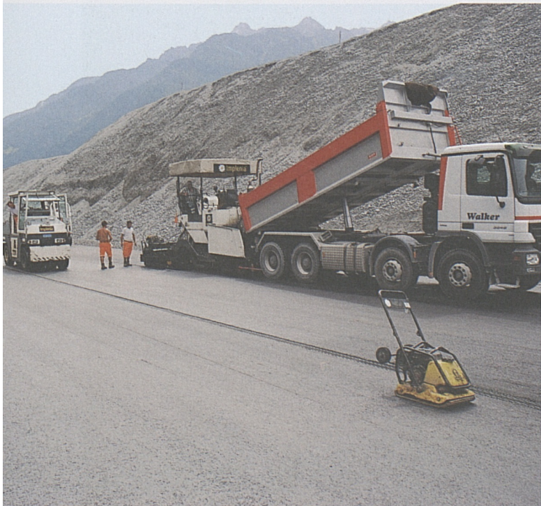
Altdorf/Rynächt: Belagseinbau auf offener Strecke.
