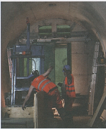
Amsteg: Einbau einer Querschlagstür.
