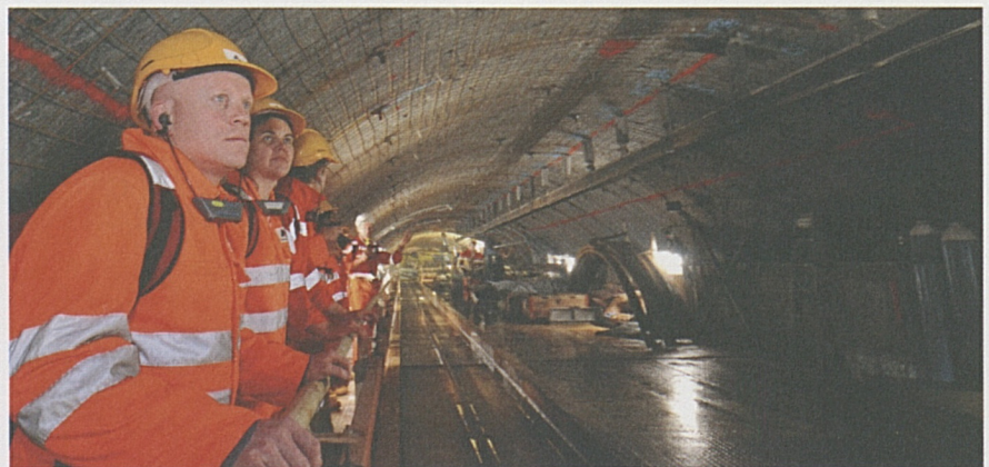
Eine der beliebtesten Baustellen der Welt: der Gotthard-Basistunnel in Erstfeld.
