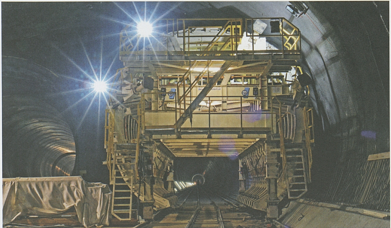
Sedrun: Weströhre mit neu montiertem Schalwagen für das Gewölbe.
