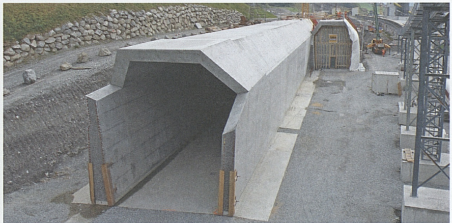
Erstfeld – Tagbautunnel Ost links und West rechts.
