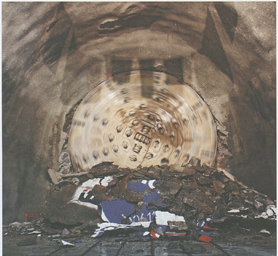
Auf dem Weg zum Ceneri-Basistunnel: Der Zugangsstollen in Sigirino ist ausgebrochen.
