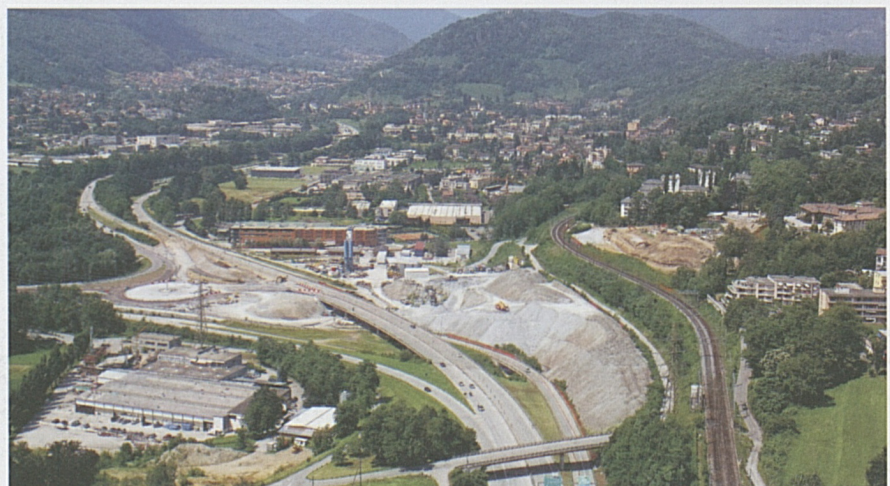
In Vezia entsteht das Südportal des Ceneri-Basistunnels.
