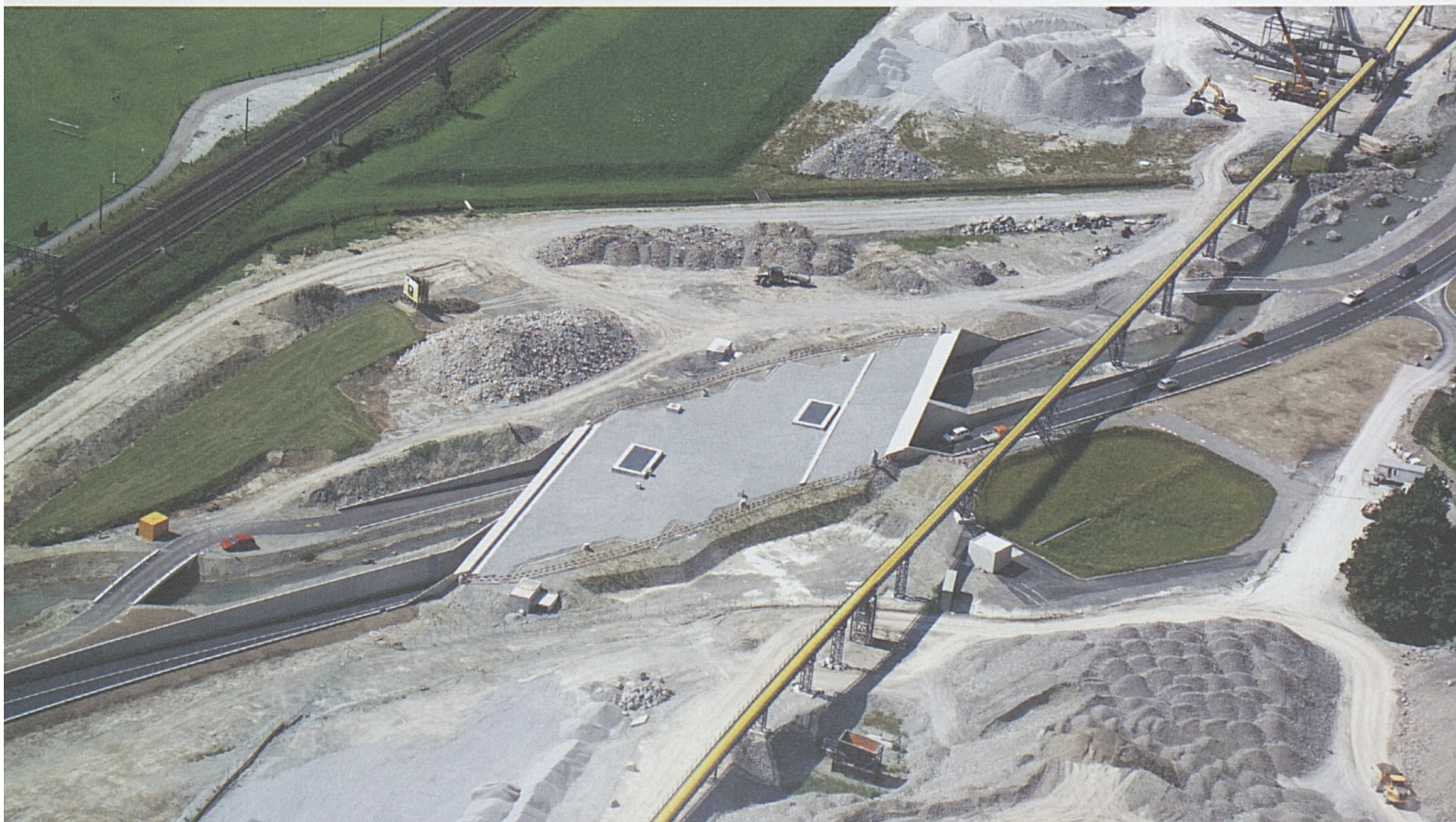
Das erste grosse Bauwerk nördlich des Gotthard-Basistunnels: die Unterführung Rynächt.
