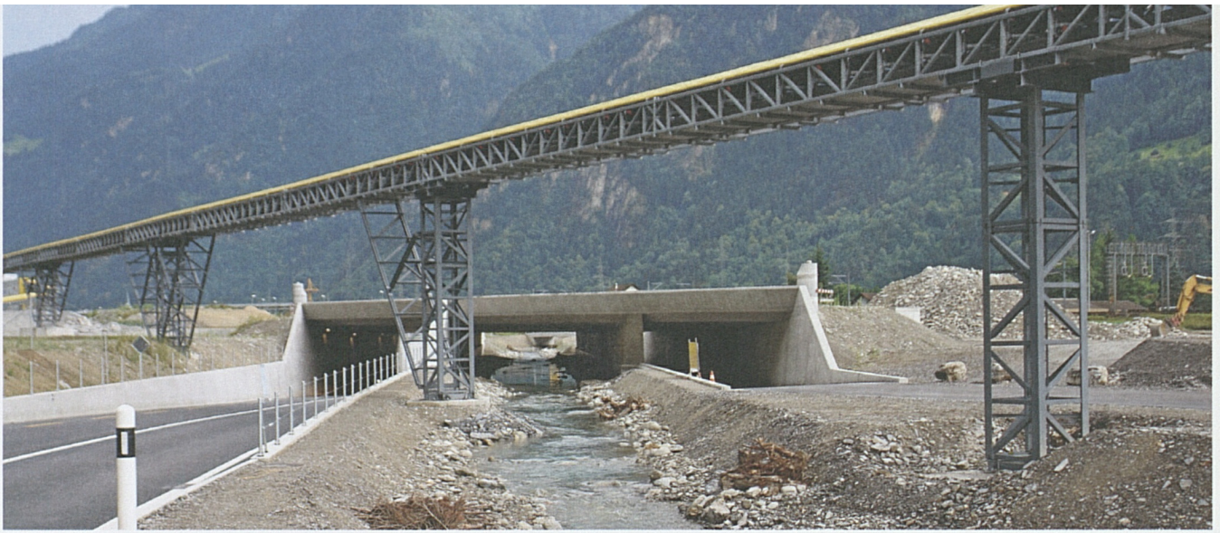
Mit dem Auto, zu Fuss oder mit dem Velo: Die Unterführung Rynächt führt alle Verkehrsteilnehmer unter der NEAT-Linie durch.
