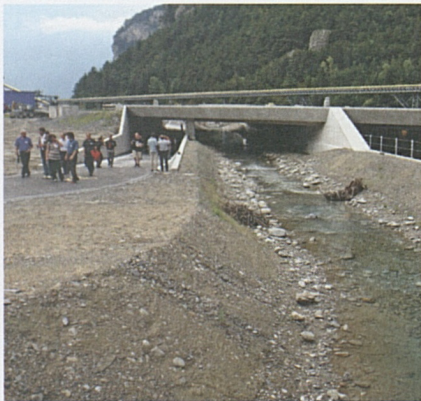
Besichtigung der Baustelle.
