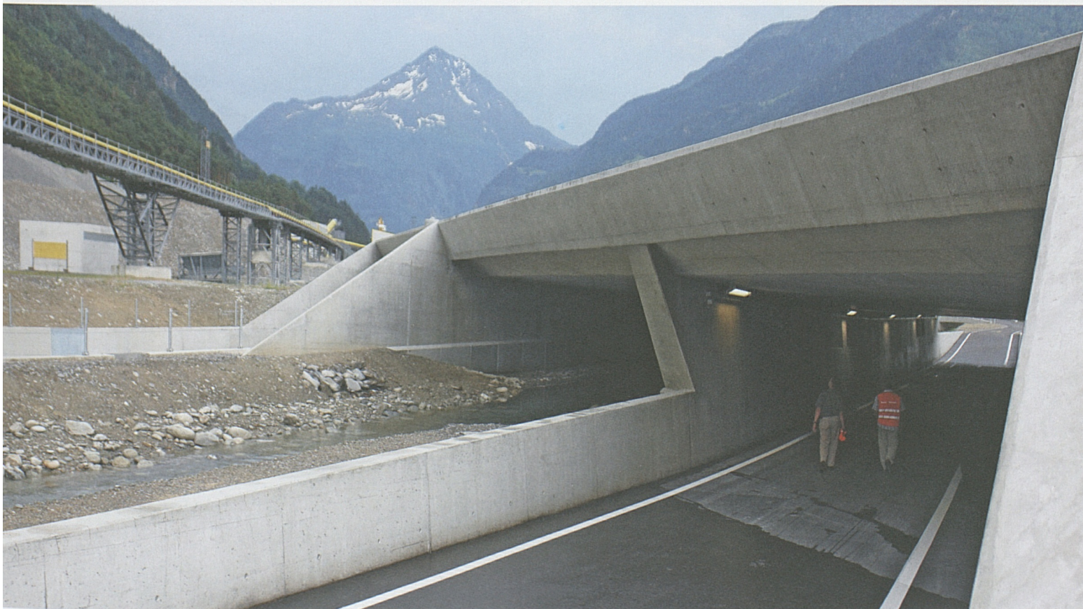
Damit der Verkehr und das Wasser fließen: Die detailgenau konstruierte Unterführung kostete rund 15 Millionen Franken.
