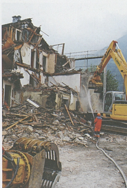
Abbrucharbeiten am Restaurant Walter Fürst.
