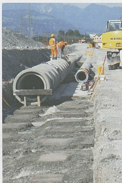
Verlegen von Trasse- und Bergwasserleitungen.
