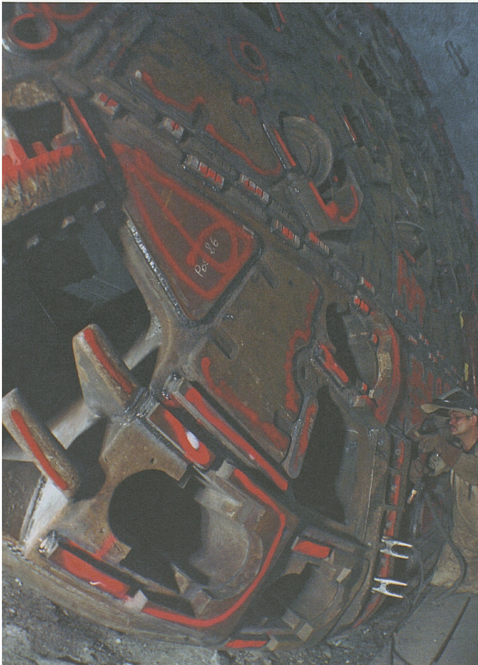
Letzte Vorbereitungen für eine schwierige Reise: Der Bohrkopf wird vor der Piora-Mulde sorgfältig revidiert.
