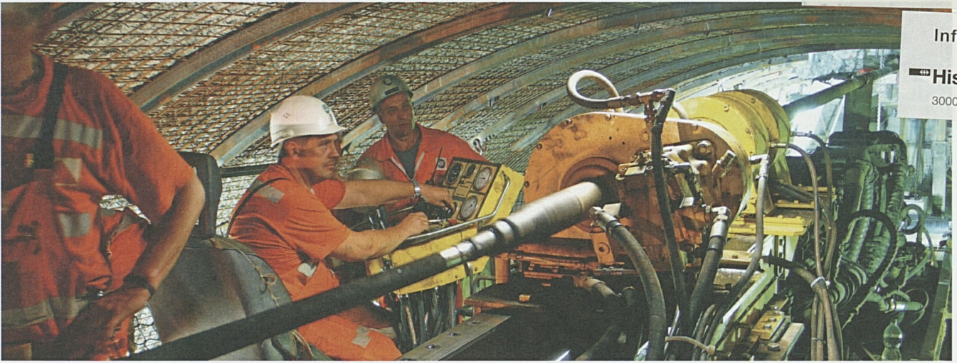
Letzte Sondierbohrung von der Tunnelbohrmaschine aus: Die Piora-Mulde enthält auf Tunnelniveau stabiles und trockenes Gestein.
