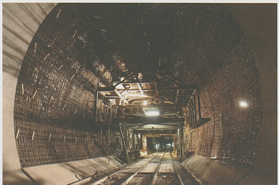
Bodio – Armierung für Betoninnenschale beim Kreuzungsbauwerk.
