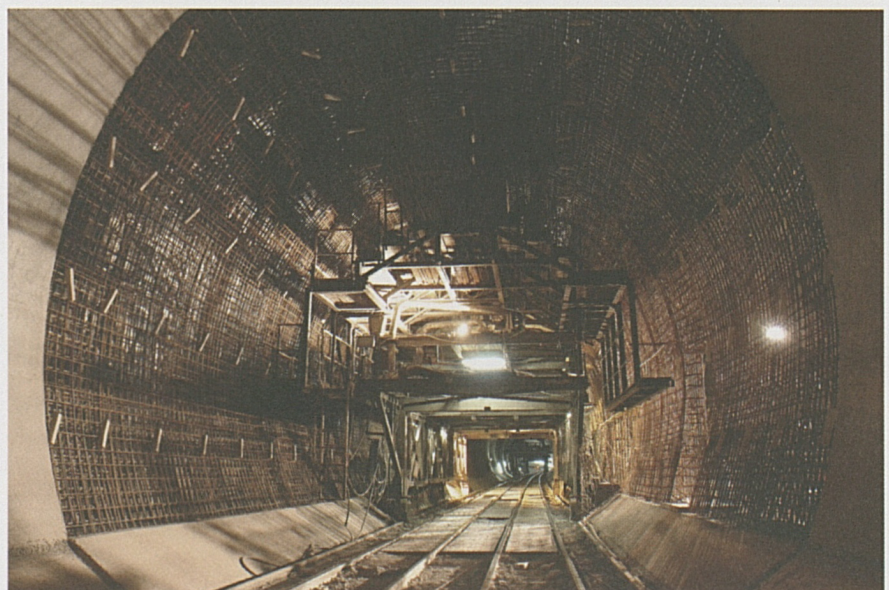
Bodio – Armierung für Betoninnenschale beim Kreuzungsbauwerk.
