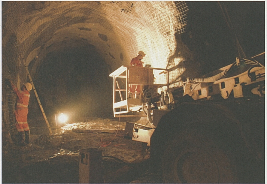
Sedrun – Sicherungsarbeiten in einem Querschlag.
