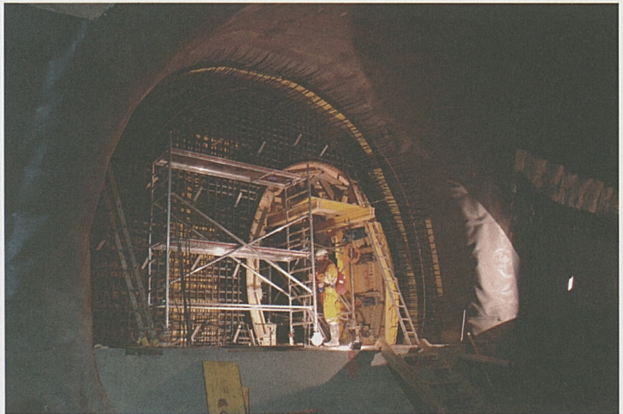
Faido – Armierung für die Betonschalung in der Nothaltestelle.
