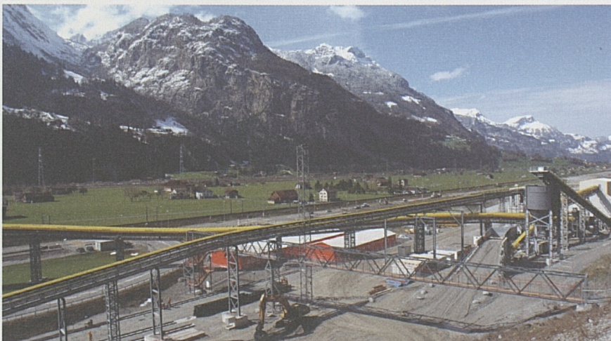
Erstfeld – alles bereit für den Leistungsvortrieb.
