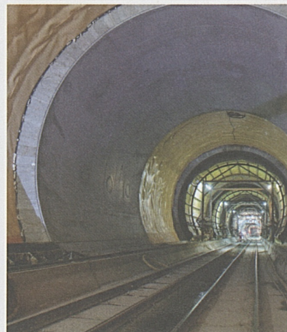
Amsteg – Schalarbeiten in der Ost-Röhre.
