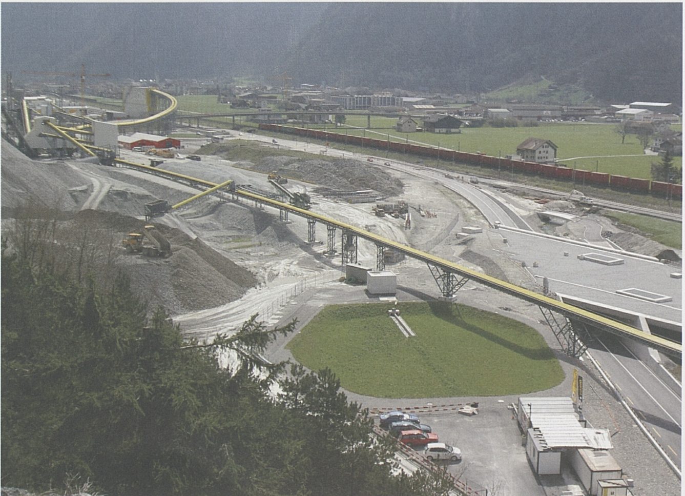
Ökologisch und leise: 18 Kilometer Förderbandanlagen alleine auf dem Installationsplatz Erstfeld.
