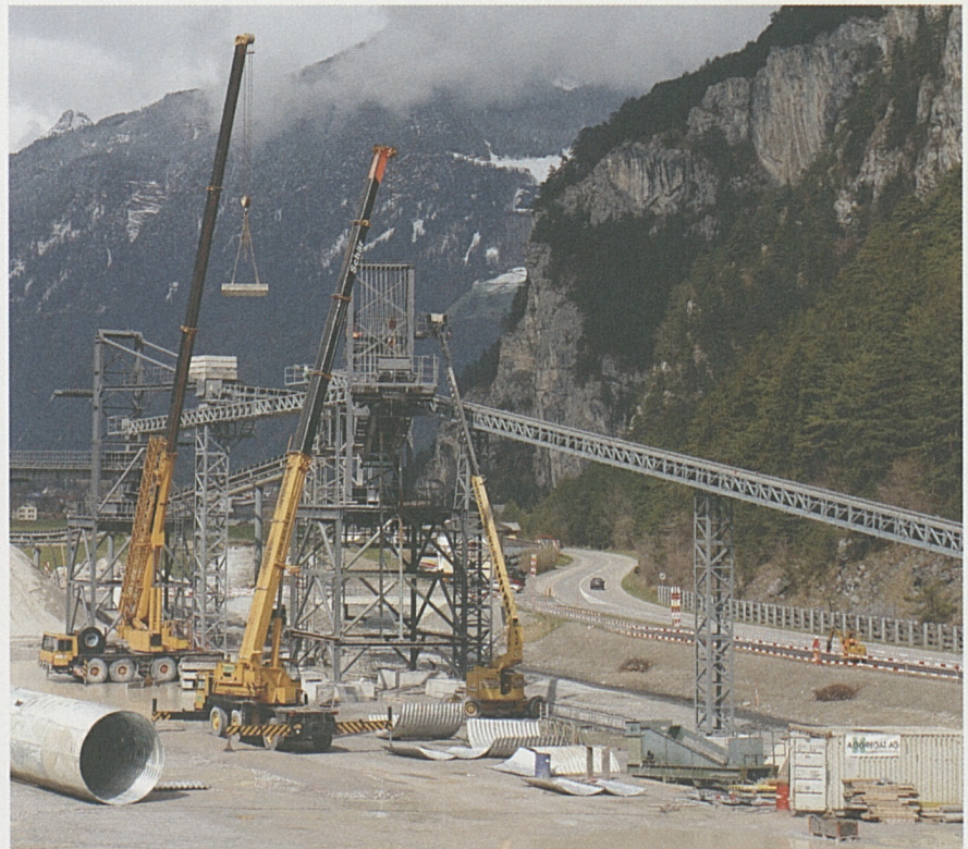
Montage von Schwenkarmen im Zwischenlager Rynächt.
