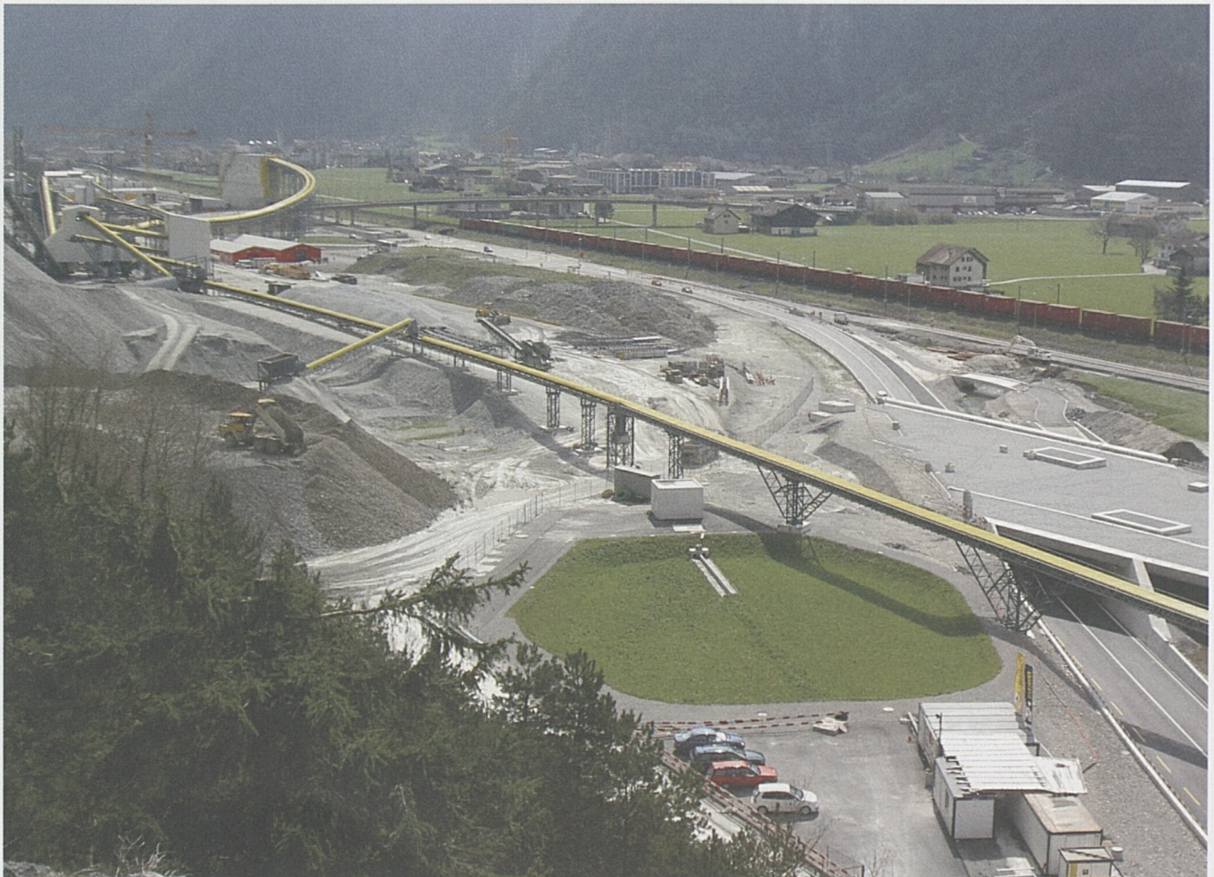
Ökologisch und leise: 18 Kilometer Förderbandanlagen alleine auf dem Installationsplatz Erstfeld.
