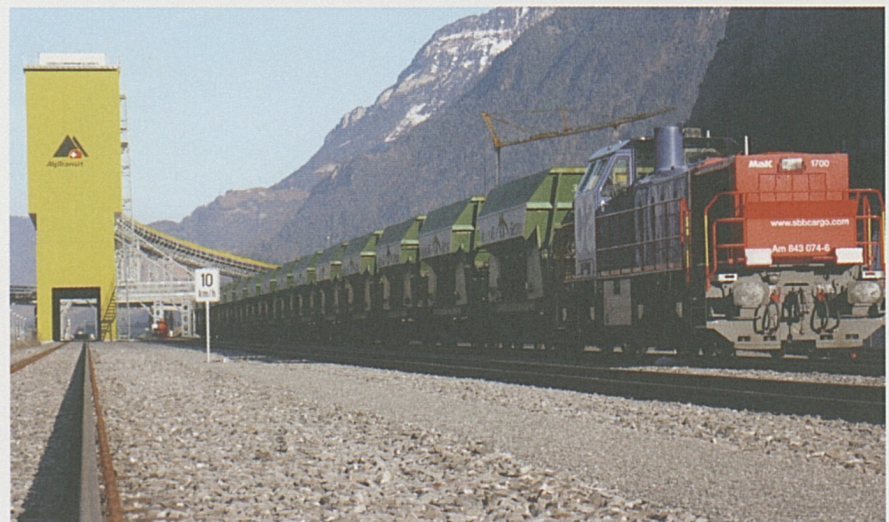
Bahnverladeanlage: Materialtransporte werden wenn immer möglich mit dem Zug abgewickelt.
