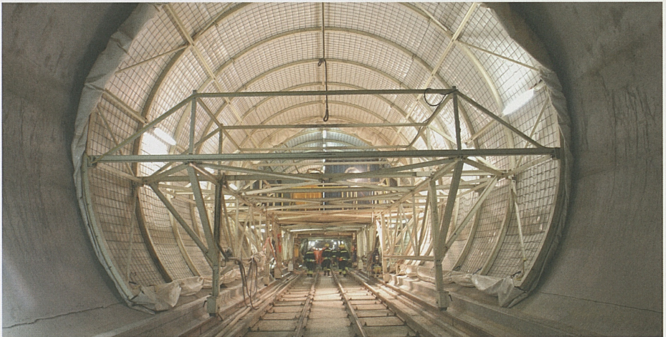
Sedrun: In der Multifunktionsstelle entsteht die Innenschale.
