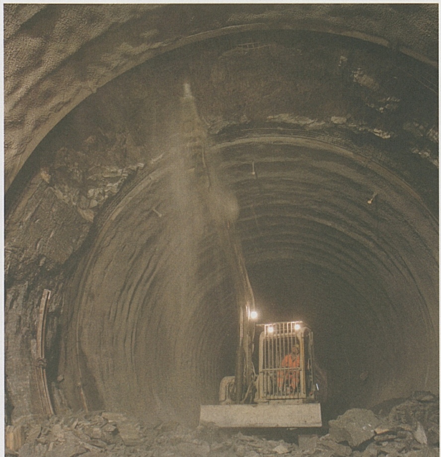
Bodio: Nachprofilierung in der Weströhre.
