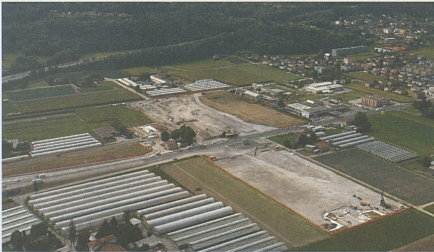
Die Baustelle in Camorino aus der Vogelperspektive.
