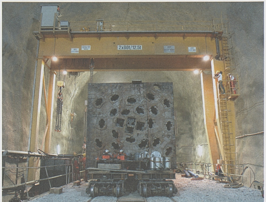
Die Demontage der beiden Amsteger Tunnelbohrmaschinen schreitet zügig voran.
