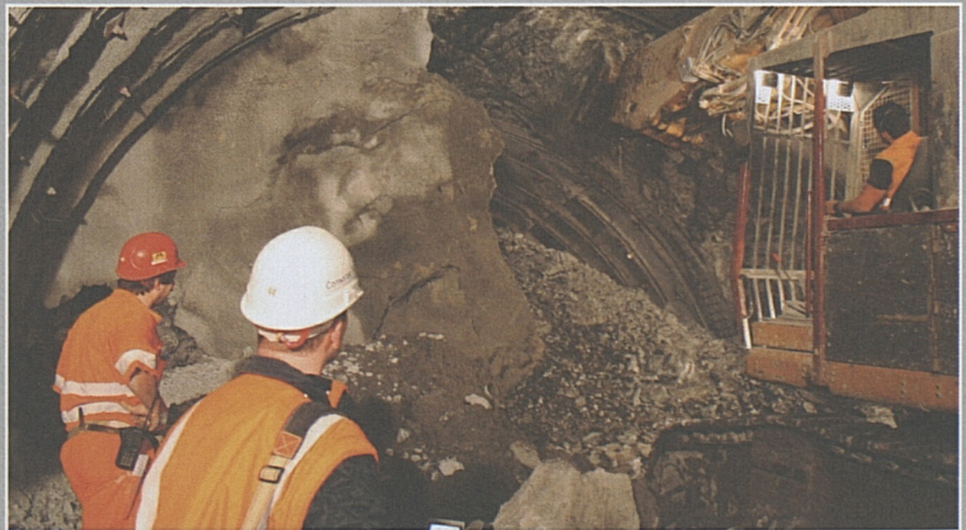
Faido – Durchschlag in der Weströhre der Multifunktionsstelle.
