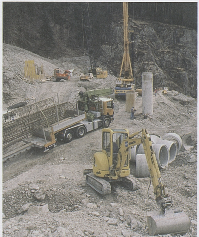
Im Voreinschnitt werden ab 2006 die Tunnelbohrmaschinen montiert.
