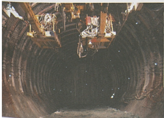
Sedrun – Vortrieb in der druckhaften Zone
