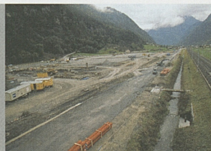
Vorbereitungsarbeiten für den Installationsplatz.
