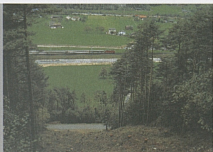
Rodungen im Bereich des Brauchwasserreservoirs.
