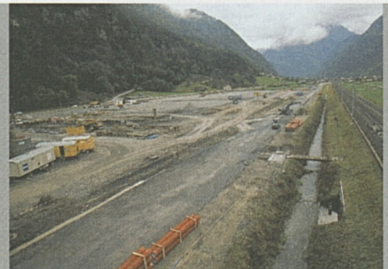
Vorbereitungsarbeiten für den Installationsplatz.
