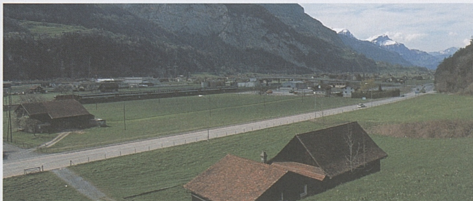
Der Baubeginn im Raum Erstfeld ist für die Eröffnung der neuen Gotthardbahn von zentraler Bedeutung.
