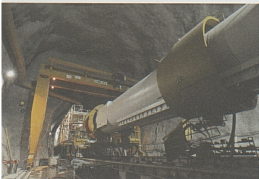
Für die TBM-Montage brauchte es zwei grosse Portal-krane mit einer Tragkraft von 2 x 80 Tonnen.
