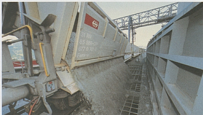
Die Umschlagleistung der Entladegasse beträgt 800 Tonnen pro Stunde.
