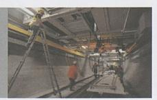
Der rund 400 Meter lange Nachläufer der TBM S-229 ist eine richtige Fabrik mit verschiedensten Maschinen und Installationen.
