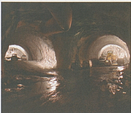
Ausbruch der Multifunktionsstelle Faido.
