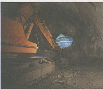
Durchstich in der Lockergesteinsstrecke.
