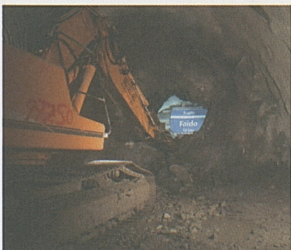
Durchstich in der Lockergesteinsstrecke.
