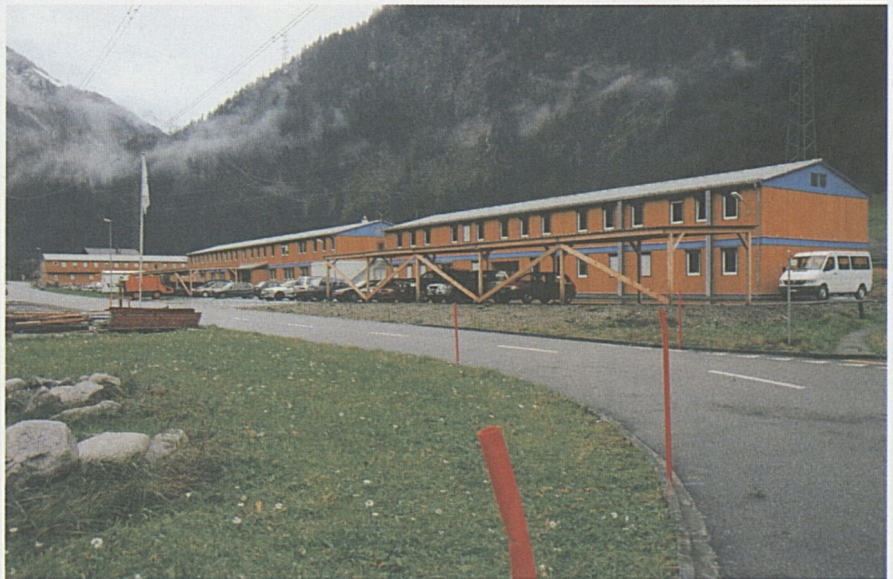
Die Bürogebäude der AlpTransit Gotthard AG, der örtlichen Bauleitung und der ARGE AGN.
