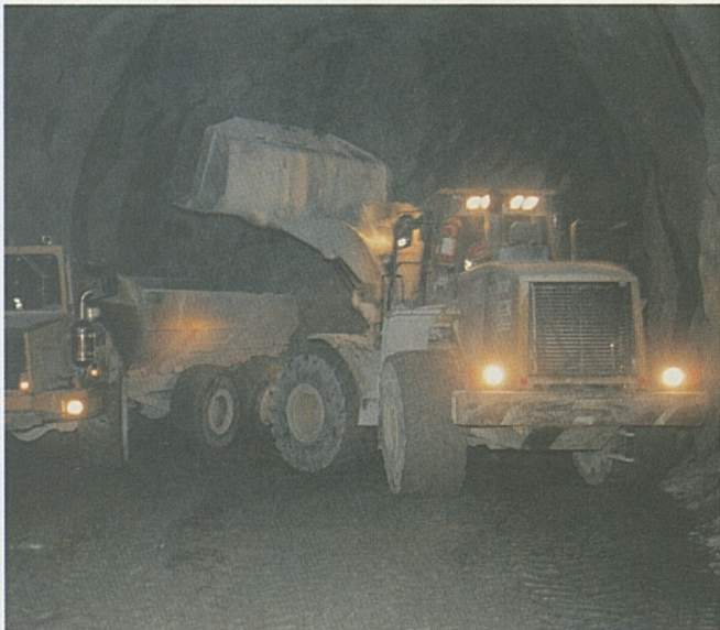
Regler Baustellenverkehr «unter Tag».
