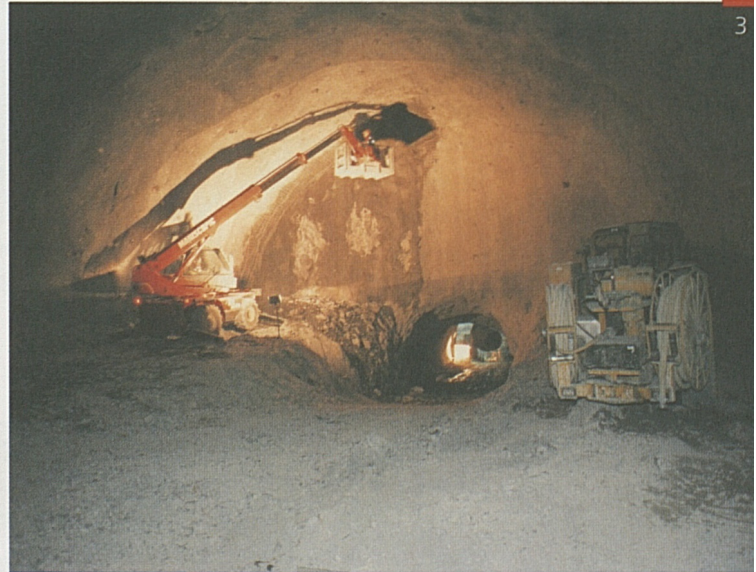
Ausbrucharbeiten in der Montagekaverne Ost.
