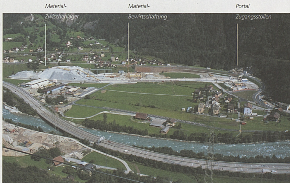
Blick auf die ATG-Baustelle Amsteg (Herbst 2000). Der 1,8 km lange Zugangsstollen zum Gotthard-Basistunnel wurde von der Arbeitsgemeinschaft Wüest/Ast Mitte Oktober fertiggestellt.
